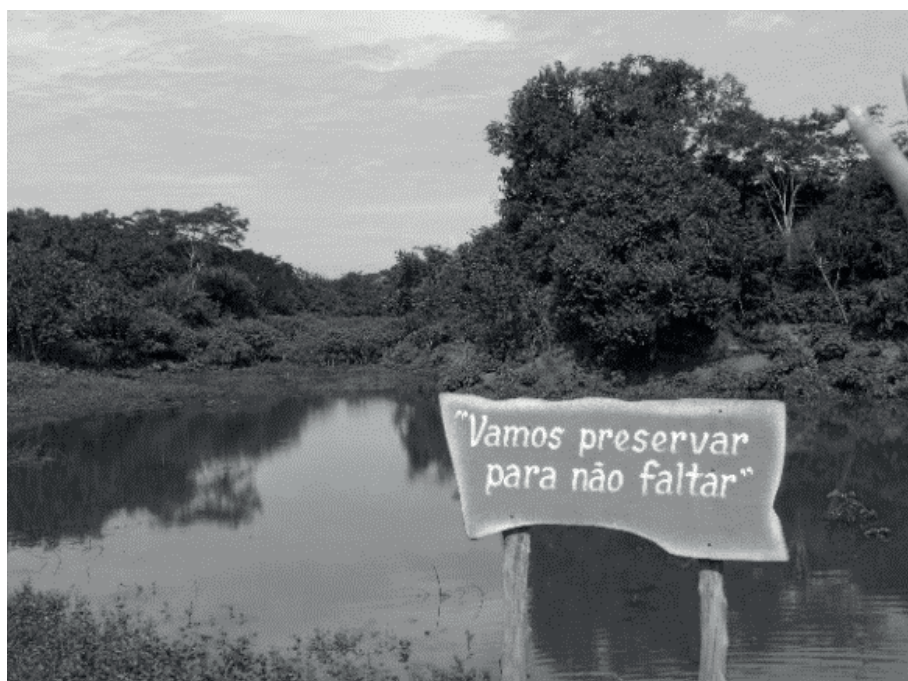
Figura 1 - Barragem I da Comunidade Cedro
