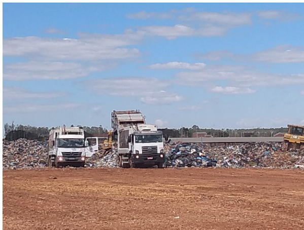
b) Frente de descarga de resíduos no ASB.
