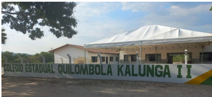
Figura 5: Vista da sede do Colégio Estadual Quilombola Kalunga.
